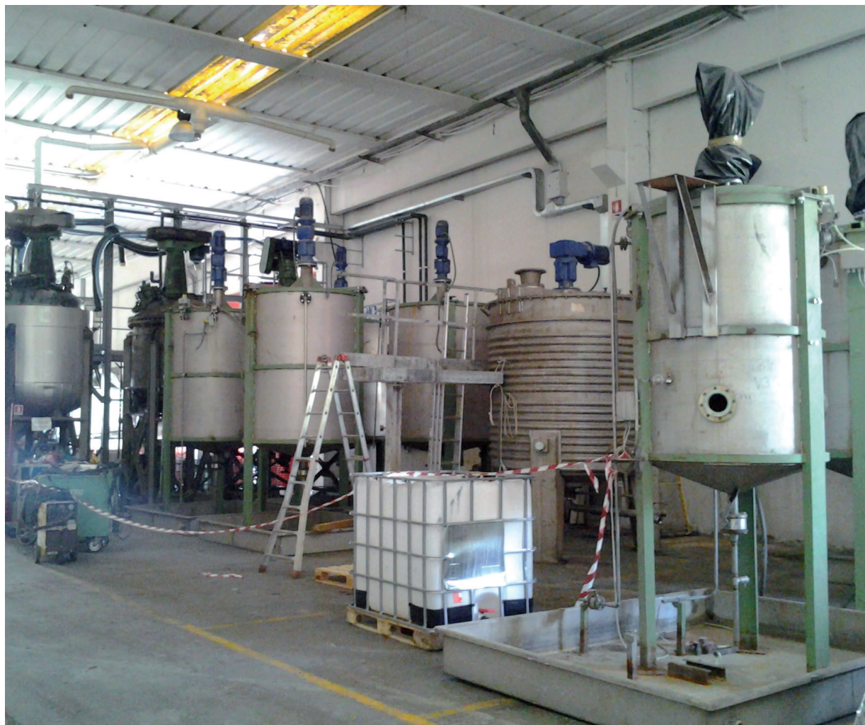
Impianto ORIM di trattamento catalizzatori in fase di montaggio
