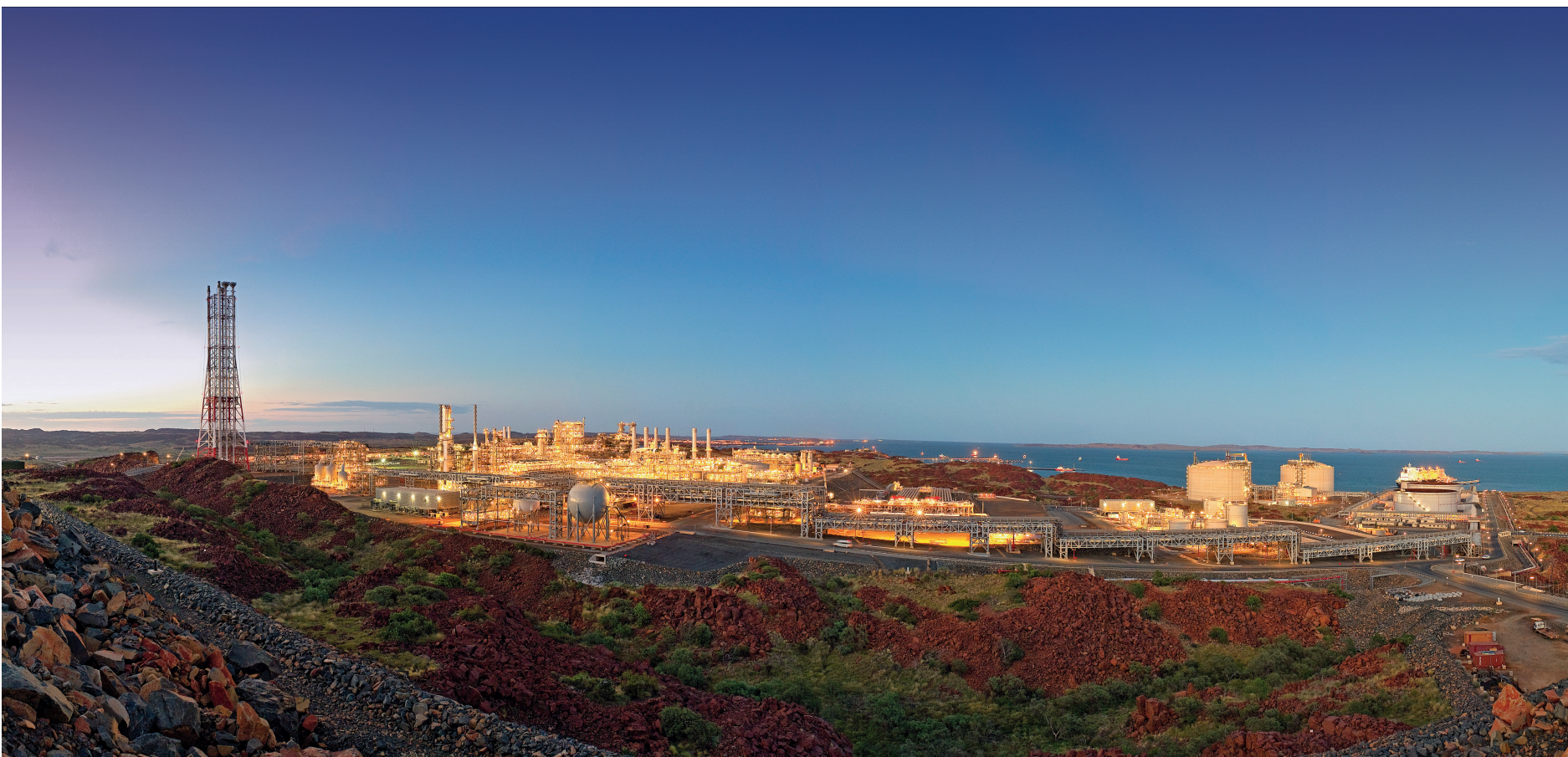
L'impianto Pluto di produzione LNG
