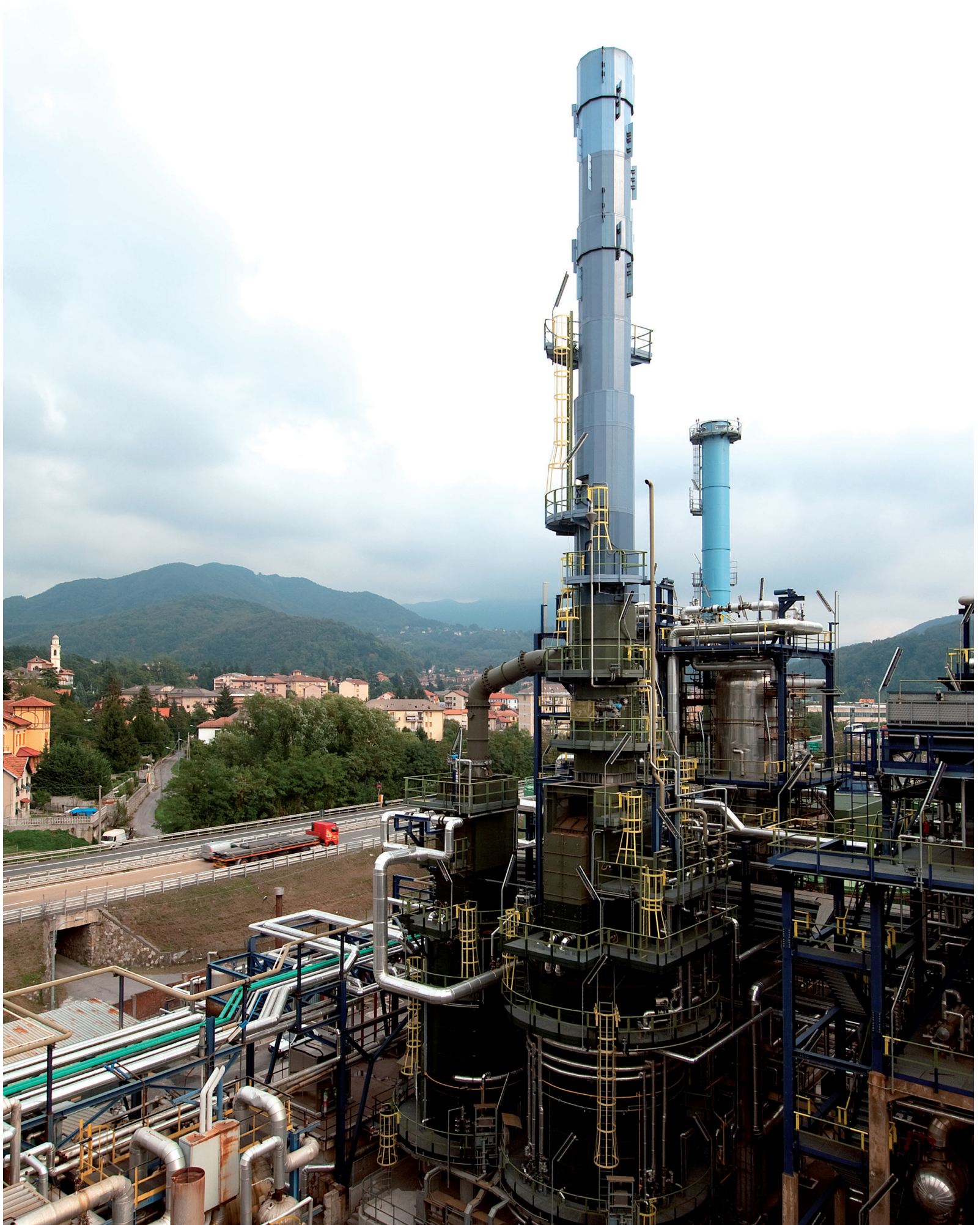
IPLM - IMPIANTO DI IDROCONVERSIONE (1.400 TG GASOLIO DA VUOTO) BUSALLA (GE)
