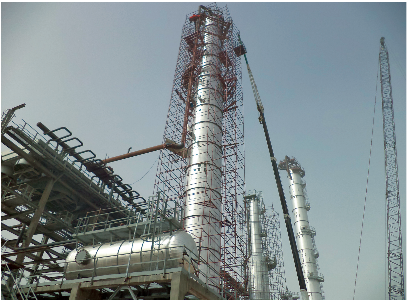
PROGETTO EPC PER PER MINISTRY OF OIL / MRC DAURA, BAGHDAD (IRAN). LIGHT NAPHTHA SPLITTER. CAPACITÀ: 13.000 BPSD
