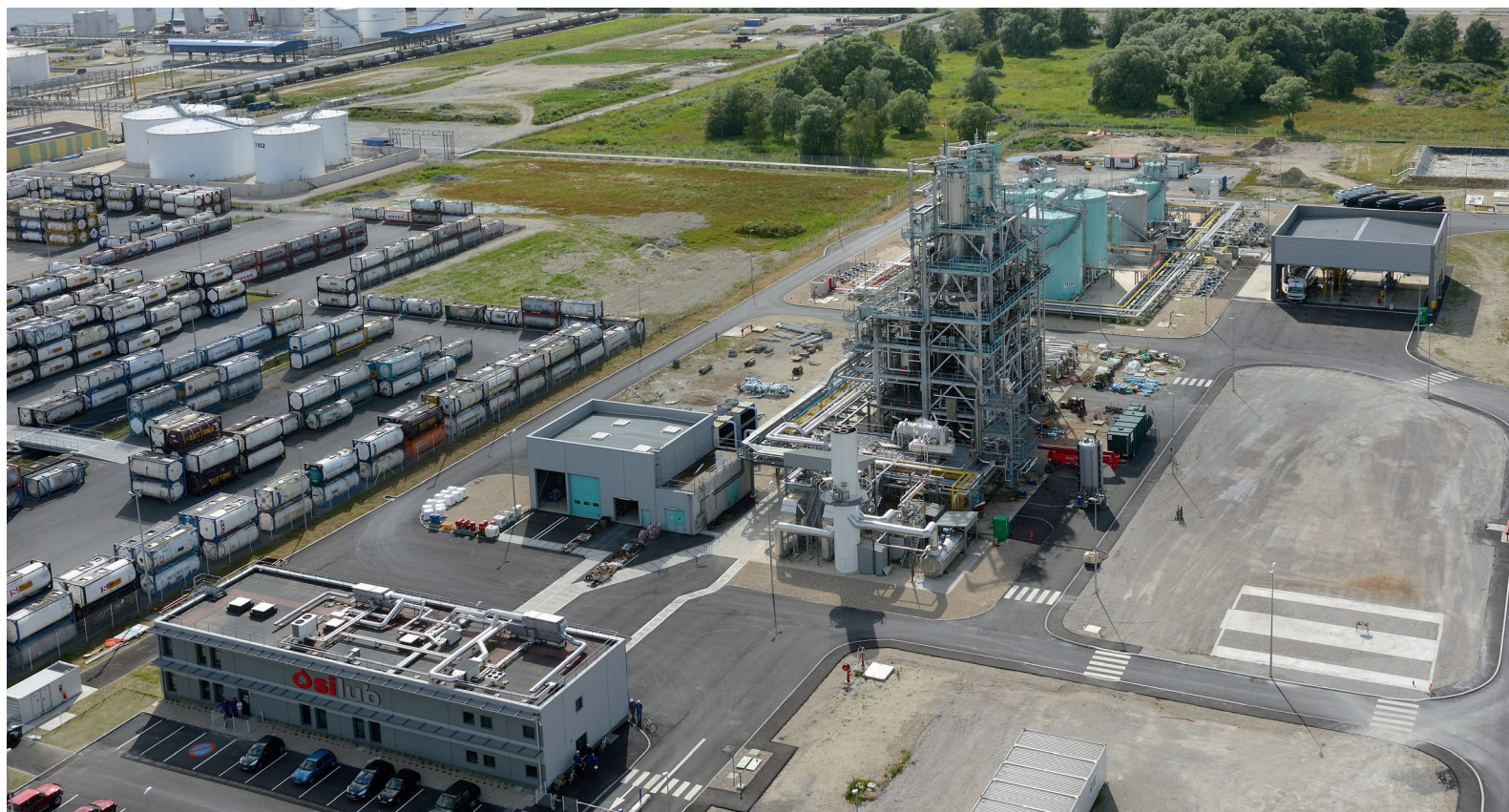
PROGETTO DI EPC PER TOTAL-VEOLIA-OSILUB GONFREVILLE L'ORCHER, FRANCIA. IMPIANTO CON CAPACITÀ DI 120.000 T/A DI OLIO LUBRIFICANTE ESAUSTO PER LA PRODUZIONE DI V.G.O. (GASOLIO DA VUOTO).
